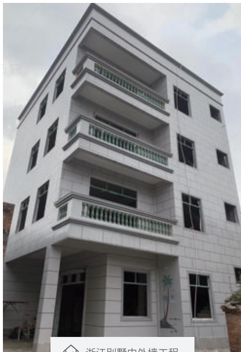
浙江别墅内外墙工程
