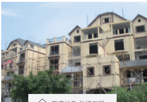
天盛长岛-外墙工程
