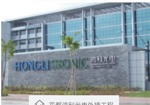
花都鸿利光电外墙工程
